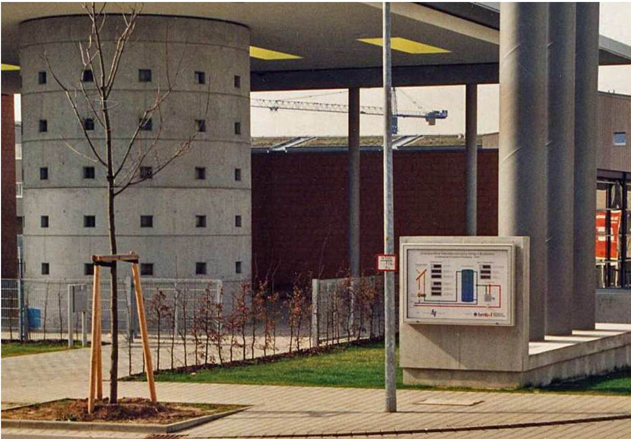
Bild 11: Anzeigetafel vor der unterirdischen Heizzentrale in Stuttgart-Burgholzhof (linker runder Bau mit Glasbausteinen: über die Heizzentrale hinausragender Teil des solaren Pufferspeichers)
